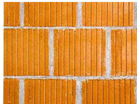
Blocuri ceramice Rost orizontal si vertical de mortar
