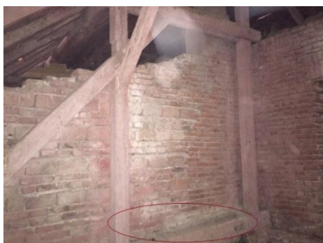
Fig. 5. Detaliu intersecție perete neîncălzit casa scării cu planșeu din lemn, spre pod neîncălzit (secțiune verticală)
