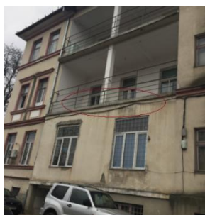
Fig. 8. Detaliu intersecție perete exterior P6 cu planșeu terasă Pl.3.2 – peste departament Bronhologie (ieșind)
