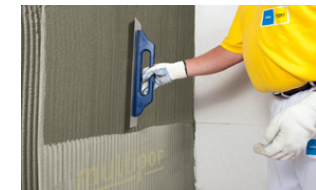
11. Inglobati corespunzator plasa de armare
