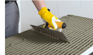
4. Aplicati mortar cu drișcă metalică cu dinți de 12 mm
