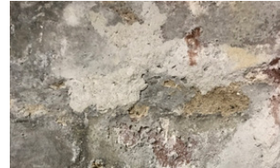
3. Echilibrați inegalitățile, îndepărtați sărurile
