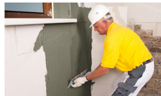
10. Pozati masa de spaclu pentru armare
