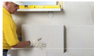
6. Apăsați placa și glisați la poziția finală
