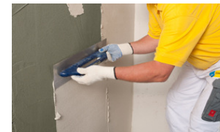
12. Nivelati cu glet in strat subtire
