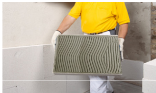
5. Lipiți pe întreaga suprafață
