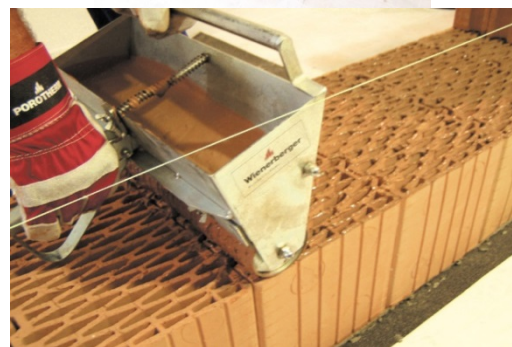
Aplicarea mortarului cu ajutorul rolei
