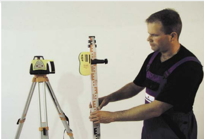
Verificarea planeității plăcii de beton
