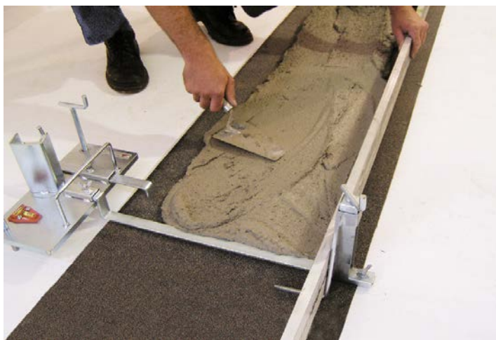
Realizarea primului rost de mortar
