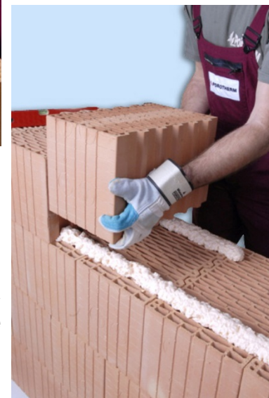
Poziționarea blocurilor ceramice
