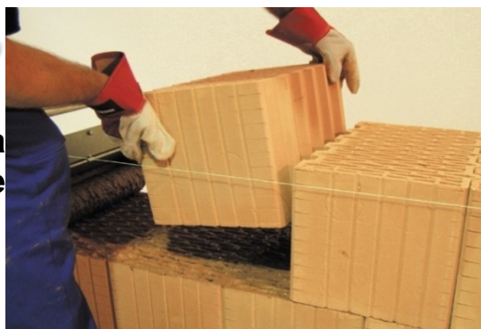
Poziționarea blocurilor ceramice
